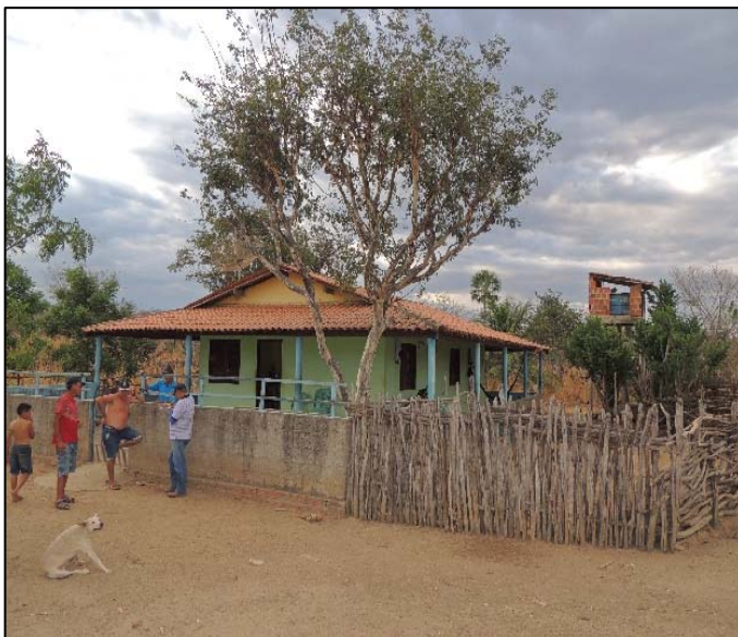
Foto 13.15 – Casa de alvenaria na área da bacia hidráulica do futuro reservatório (E-303.201; N-9.580.311).
