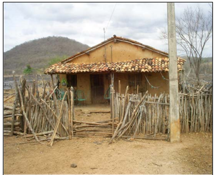
Foto 13.16 - Rede elétrica de baixa tensão que atende os imóveis da área da bacia hidráulica do futuro reservatório (E-303.021; N-9.579.283).
