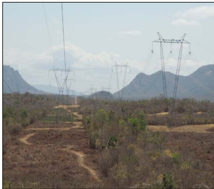
Foto 13.18 - Linhas de alta tensão da CHESF que interceptam a bacia hidráulica do futuro reservatório em seu trecho mais a montante (E-301.661; N-9.576.553).
